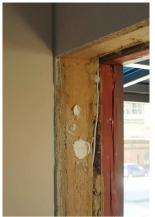
dämmungen aber aus bauphysikalischen Gründen nicht unproblematisch und grundsätzlich als Mittelweg zu sehen sind, musste die Wahl des Dämmstoffes sowie der gesamte Konstruktionsaufbau den hygrothermischen Verhältnissen der Fachwerkfassade genau angepasst werden. Die gewählte Innendämmung ist besonders geeignet für Fachwerkkonstruktionen. Sie besteht aus der Kombination von Lehmputzen mit integrierter Hei-
