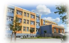
Abbildung 109 Gesamtschule Immanuel Kant Falkensee
