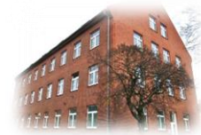
Abbildung 69 Grundschule "Geschwister Scholl" Rathenow
