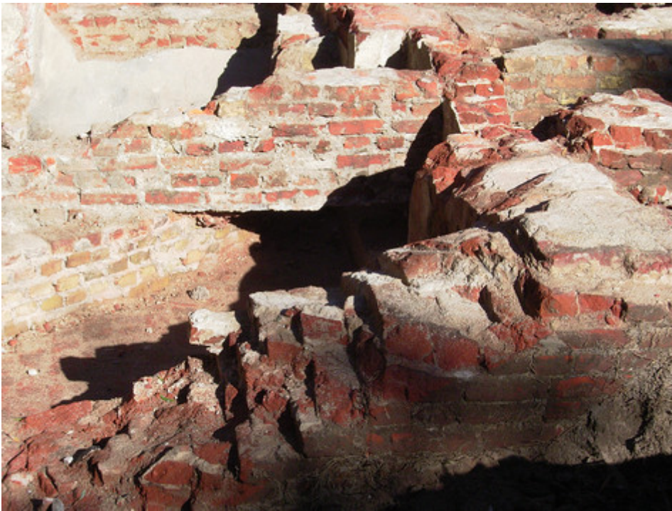
Ostseite: ab August 2006 Balkon- und Treppenabbruch und Freilegung des Gewölbes
