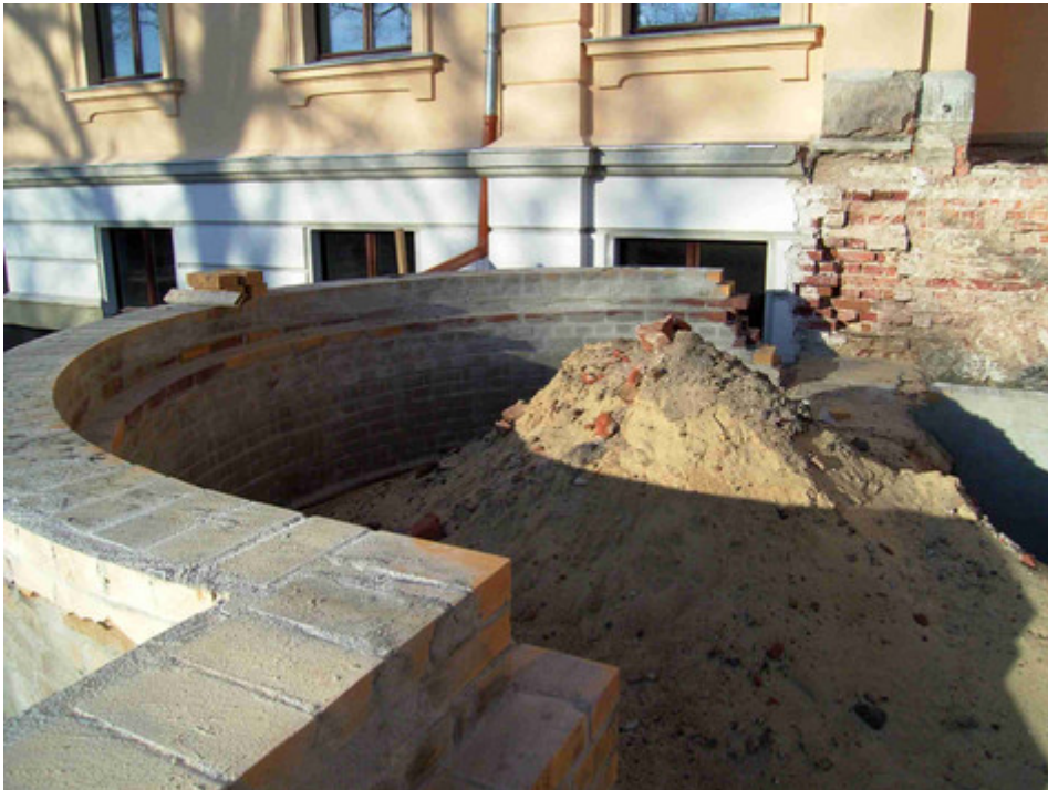
ausgewählter Sanierungsabschnitt: Aufbau der Terasse an der Straßenseite des Schlosses
